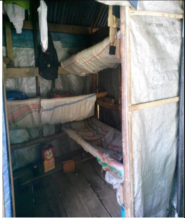
临时工人住房由非耐用材料建造，直接在地面搭设，没有通风或照明，没有电、自来水、卫生或烹饪设施，没有足够的污水处理设施、卫生设施和垃圾处理设施。
